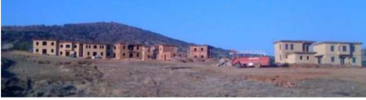
Sonsuz Şükran Köyü İnşaatleri / Kasım 2010
